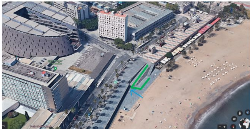
Figura 11: Imagen real de la zona final de demostración para caso de uso BUS AUTÓNOMO
